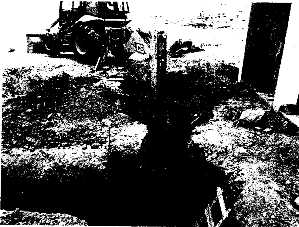
FOTO N° 22: Acomodo de roca interfiriendo con cimentaciones de Sub estación eléctrica.
