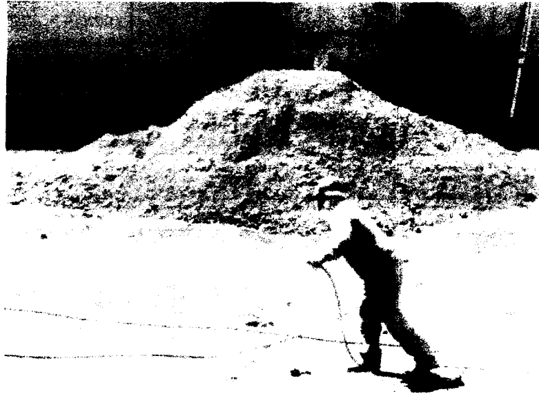
Foto 16: Colaborador regando la tierra antes de moverla para minimizar el polvo
