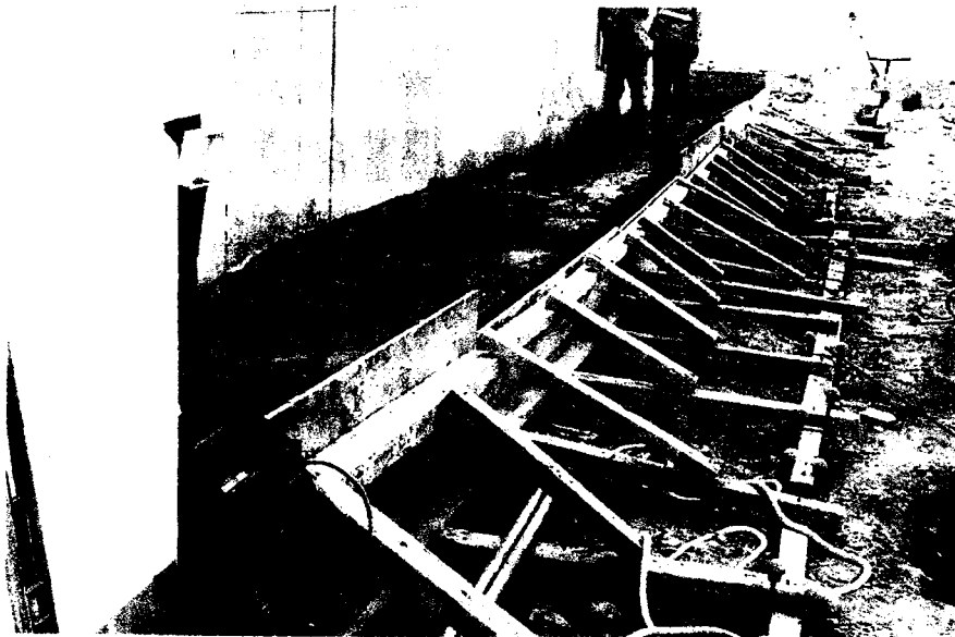
FOTO 9: uso de capuchones para evitar accidentes por colisiones con fierros
