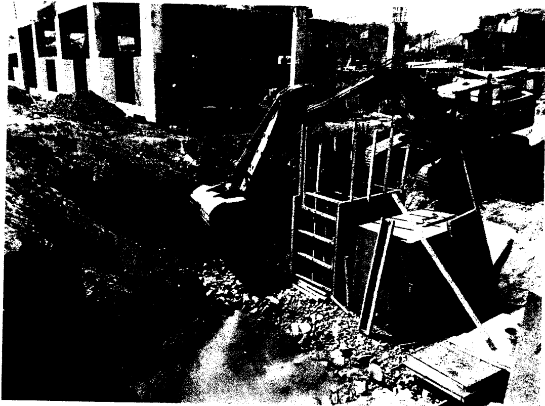
FOTO N° 20: Acomodo de roca interfiriendo con cimentaciones.
