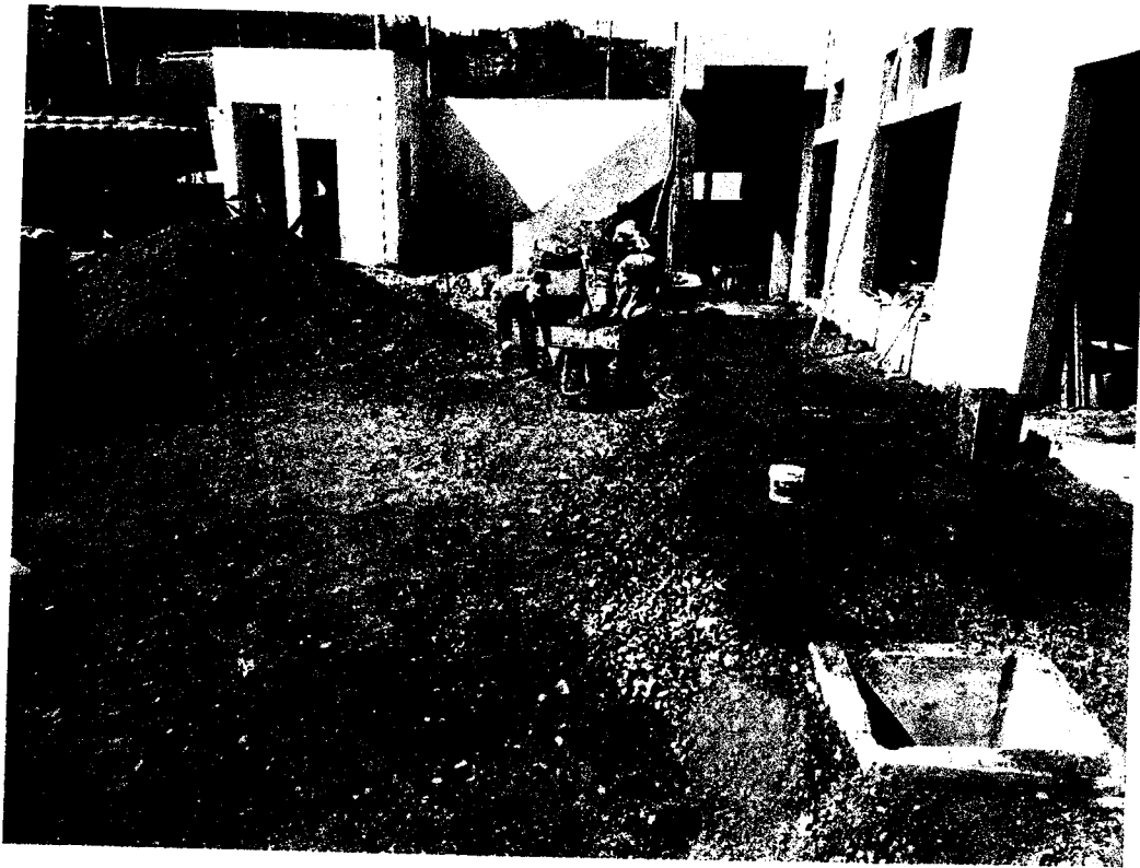
FOTO N° 03: Relleno con afirmado y compactado en veredas y pavimento rígido, área de administración.
