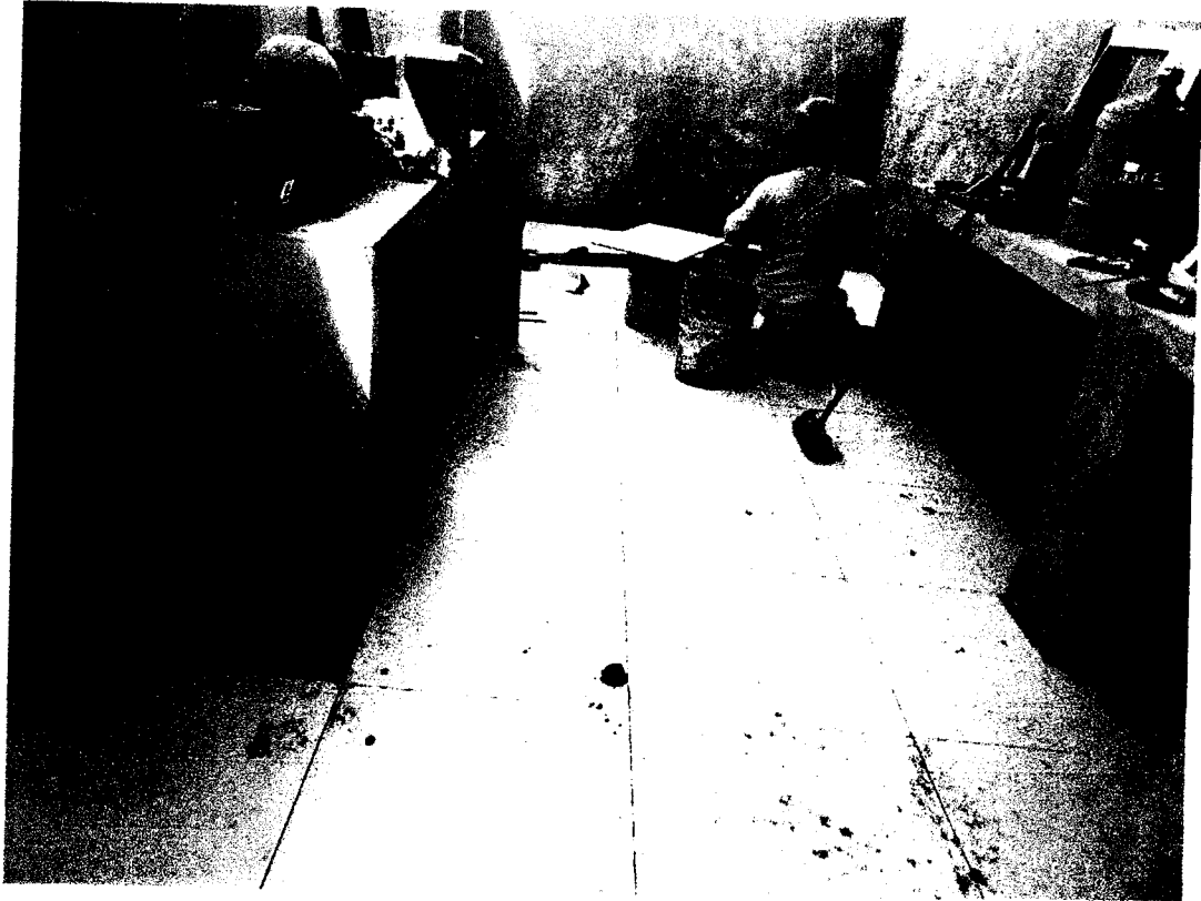
FOTO N° 19: Colocado de porcelanato en piso y muros.
