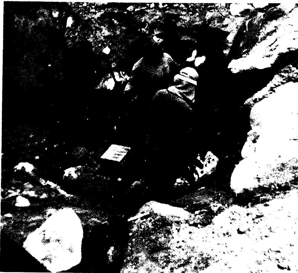
FOTO N° 23: Acomodo de roca interfiriendo con cimentaciones de cerco perimétrico.
